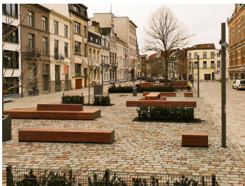
Riolerings- en bestratingswerken Moorkensplein
