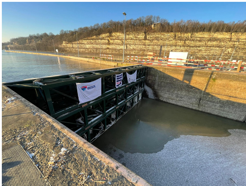
Rénovation de l'écluse de Lanaye.
