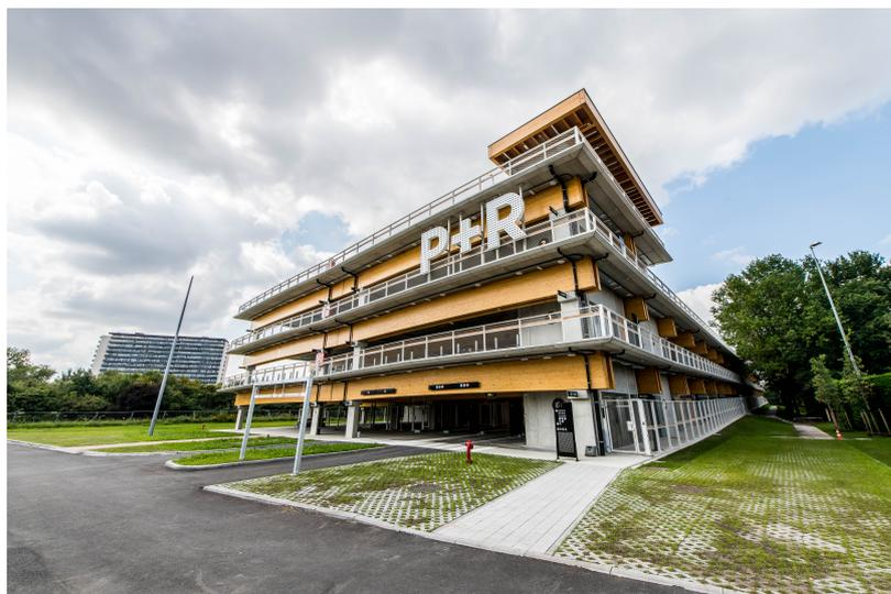
Ce parking de délestage « park and ride » (12 000 m<sup>2</sup>) ultramoderne de Merksem peut accueillir 690 voitures et 150 bicyclettes et dispose de 18 bornes de recharge pour les véhicules électriques. Le bâtiment se distingue par sa construction légère et ouverte, dans lequel les poutres en bois jouent le rôle principal.
