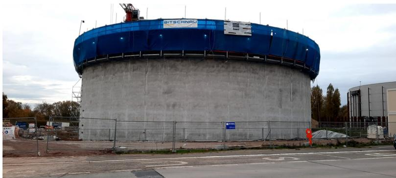
Construction d'un réservoir d'eau potable cylindrique en béton d'un diamètre intérieur de 38,4 m, d'un mur (via un coffrage coulissant) d'une épaisseur de 45 cm et d'une hauteur de 16,5 m, y compris la construction des abords.
