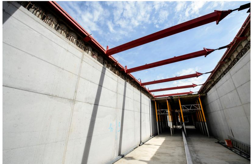
Bassin d'orage relié au système d'égouts qui est en mesure de collecter 10.000 m<sup>3</sup> d'eau lors des pluies d'orage violentes afin de désengorger les égouts. L'eau ainsi stockée est déversée dans l'un des principaux collecteurs de Bruxelles, la moitié par l'intermédiaire d'une évacuation gravitaire, l'autre moitié au moyen de pompes.
