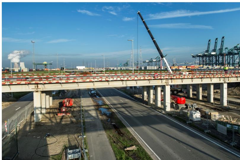
Construction d'un pont pour camions au-dessus de la St Antoniusweg au Deurganckdok sur la rive gauche d'Anvers. Le pont pour camions a été construit sur le site du terminal européen de MSC PSA, mais s'étend sur le domaine public. Le pont a une longueur de 77m et une largeur de 12m.
