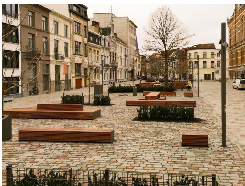
Riolerings- en bestratingswerken Moorkensplein
